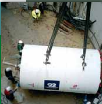
Tunnelier / Hauer / David Poggi
